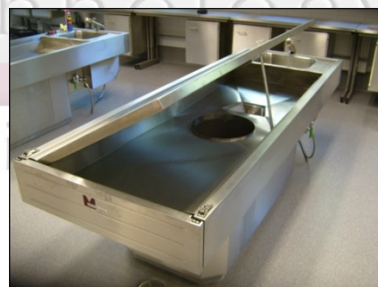
Beispiel einer sog. „Dom“-Absaugung, die wir als Sonderausführung nur einmal hergestellt haben. Der Boden ist nicht glatt und das Ablufrohr mündet direkt im Abluft-System
