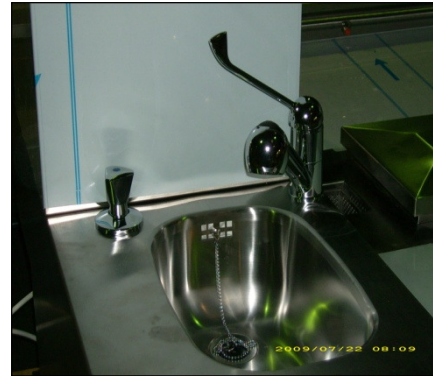
Spüle mit 25mm Radius, Ellbogen-Armatur und flexibler Brause (1,5m). Links: Ventil für Ringspülsystem unterhalb der Arbeitsfläche
