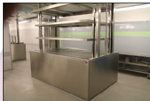
MA-1347 für 6 Körper (in Bodenvertiefung eingesetzt) in ausgefahrenem Zustand
