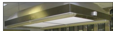
Die Zulufthaube erzeugt ein Laminar-Flow-System und ist besonders effektiv in der Rechtsmedizin mit starkem Geruchsfall
