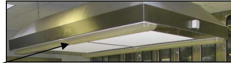
Die Zulufthaube erzeugt ein Laminar-Flow-System und ist besonders effektiv in der Rechtsmedizin mit starkem Geruchsanfall
