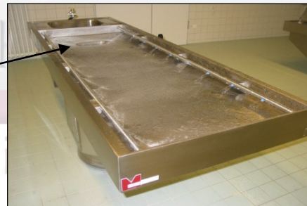
Seziertisch mit Randabsaugung und Flächenspülung. Steuerung über Ventil. Anmerkung: glatte Fläche unterhalb der perforierten Arbeitsfläche
