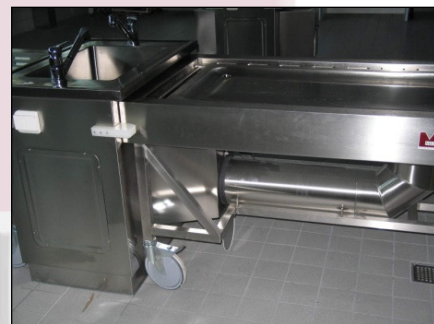
Abluftleitung in der Verbindung mit der Andock-Station
