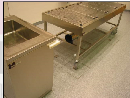
Abluftleitung vor der Verbindung mit der Andock-Station
